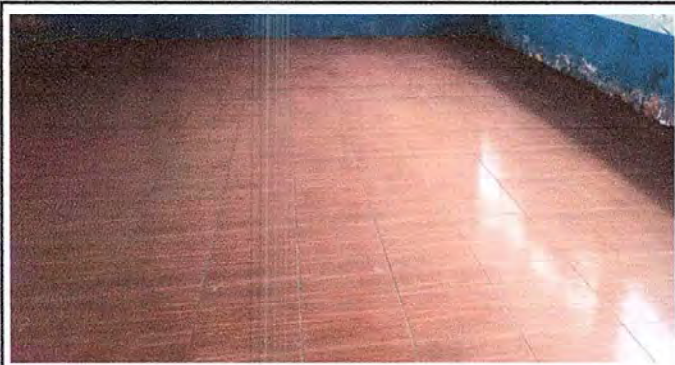
FOTO 3: INSTALACION DE PISO CERAMICO TIMBORANA EN AULAS, MEJORANDO LAS CONDICIONES DEL AMBIENTE ESCOLAR.
