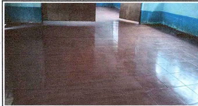
FOTO 4: INSTALACION DE PISO CERAMICO TIMBORANA EN AULAS, MEJORANDO LAS CONDICIONES DEL AMBIENTE ESCOLAR.
