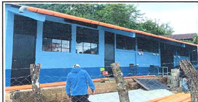
FOTO 6: INSTALACION DE PUERTAS DE METAL PRENSADA CON SU RESPECTIVO PASADOR Y CANDADO, PARA SEGURIDAD DE LOS DIFERENTES MODULOS ESCOLARES.
