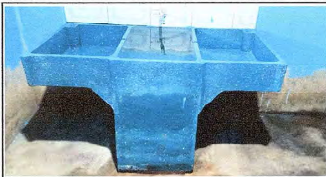
FOTO 14: MEJORAMIENTO DE PILA EN MAL ESTADO, POR PILA NUEVA DE DOS ALAS PARA MEJORAR LAS CONDICIONES DEL AMBIENTE DE COCINA.
