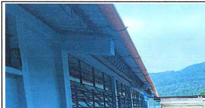
FOTO 10: INSTALACION FINAL DE TUBERIAS PVC DE 4" TIPO CANAL, PARA MEJORAR LAS CAPTACIONES DE AGUA PLUVIAL.
