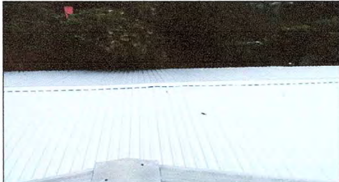
FOTO 2: INSTALACION DE LAMINA TROQUELADA CALIBRE 26 ALUZINC PARA MEJORAR LAS CONDICIONES DE BODEGA, COCINA Y AULAS.
