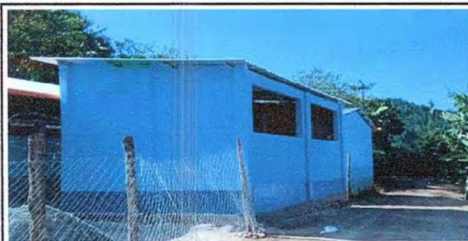
FOTO 11: SUSTITUCION DE PARED DE LAMINA POR BLOCK FORMAL, INSTALACION DE ESTRUCTURA DE METAL Y CUBIERTA DE LAMINA PARA MEJORAR LAS CONDICIONES DEL AMBIENTE ESCOLAR.
