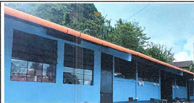
FOTO 9: INSTALACION FINAL DE TUBERIAS PVC DE 4" TIPO CANAL, PARA MEJORAR LAS CAPTACIONES DE AGUA PLUVIAL.
