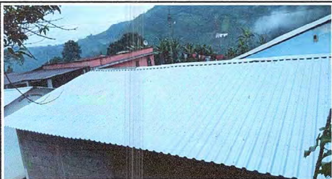
FOTO 1: INSTALACION DE LAMINA TROQUELADA CALIBRE 26 ALUZINC PARA MEJORAR LAS CONDICIONES DE BODEGA, COCINA Y AULAS.
