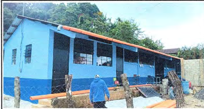
FOTO 8: PINTURA EN PAREDES INTERIOR Y EXTERIOS BODEGA, COCINA Y AULAS MEJORANDO TODOS LOS AMBIENTES ESCOLARES.
