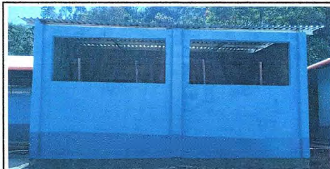
FOTO 12: SUSTITUCION DE PARED DE LAMINA POR BLOCK FORMAL, INSTALACION DE ESTRUCTURA DE METAL Y CUBIERTA DE LAMINA PARA MEJORAR LAS CONDICIONES DEL AULA.
