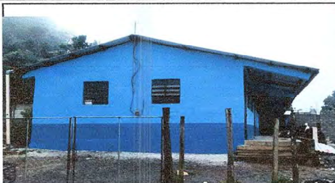
FOTO 13: MEJORAMIENTO DE PARED CON SU RESPECTIVO REPELLO Y PINTURA PARA MAYOR DURABILIDAD DE LAS MEJoras DEL AMBIENTE ESCOLAR.
