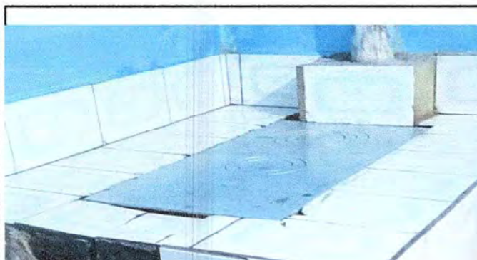
FOTO 15: MEJORAMIENTO DE POLLETON CON SU RESPECTIVA PLANCHA DE METAL MEJORANDO CONDICIONES DEL AREA DE COCINA.
