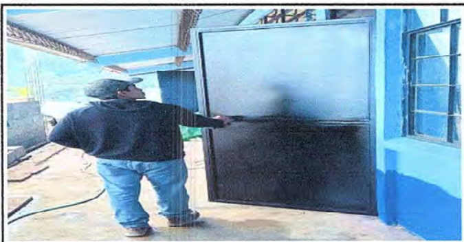
FOTO 5: INSTALACION DE PUERTAS DE METAL PRENSADA CON SU RESPECTIVO PASADOR Y CANDADO, PARA SEGURIDAD DE LOS DIFERENTES MODULOS ESCOLARES.
